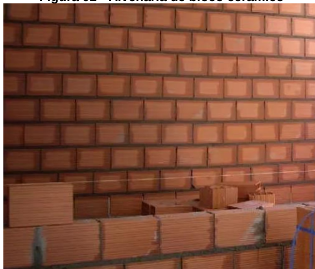
Figura 02 - Alvenaria de bloco cerâmico
