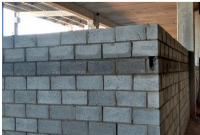
Figura 03 - Alvenaria de bloco de concreto
