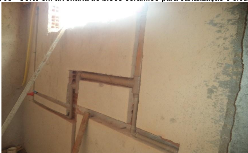
Figura 08 - Corte em alvenaria de bloco cerâmico para canalização e eletrodutos
