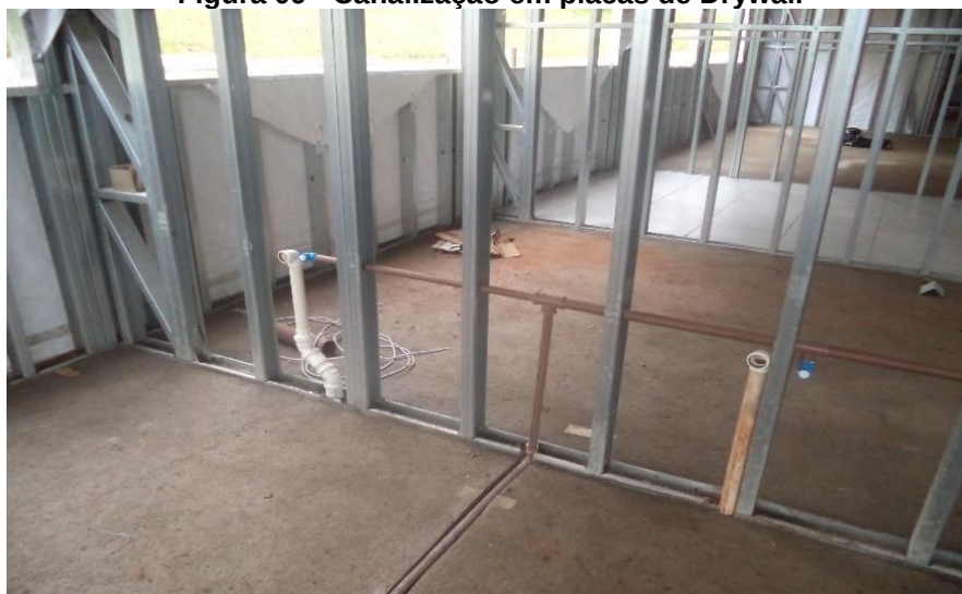
Figura 09 - Canalização em placas de Drywall
